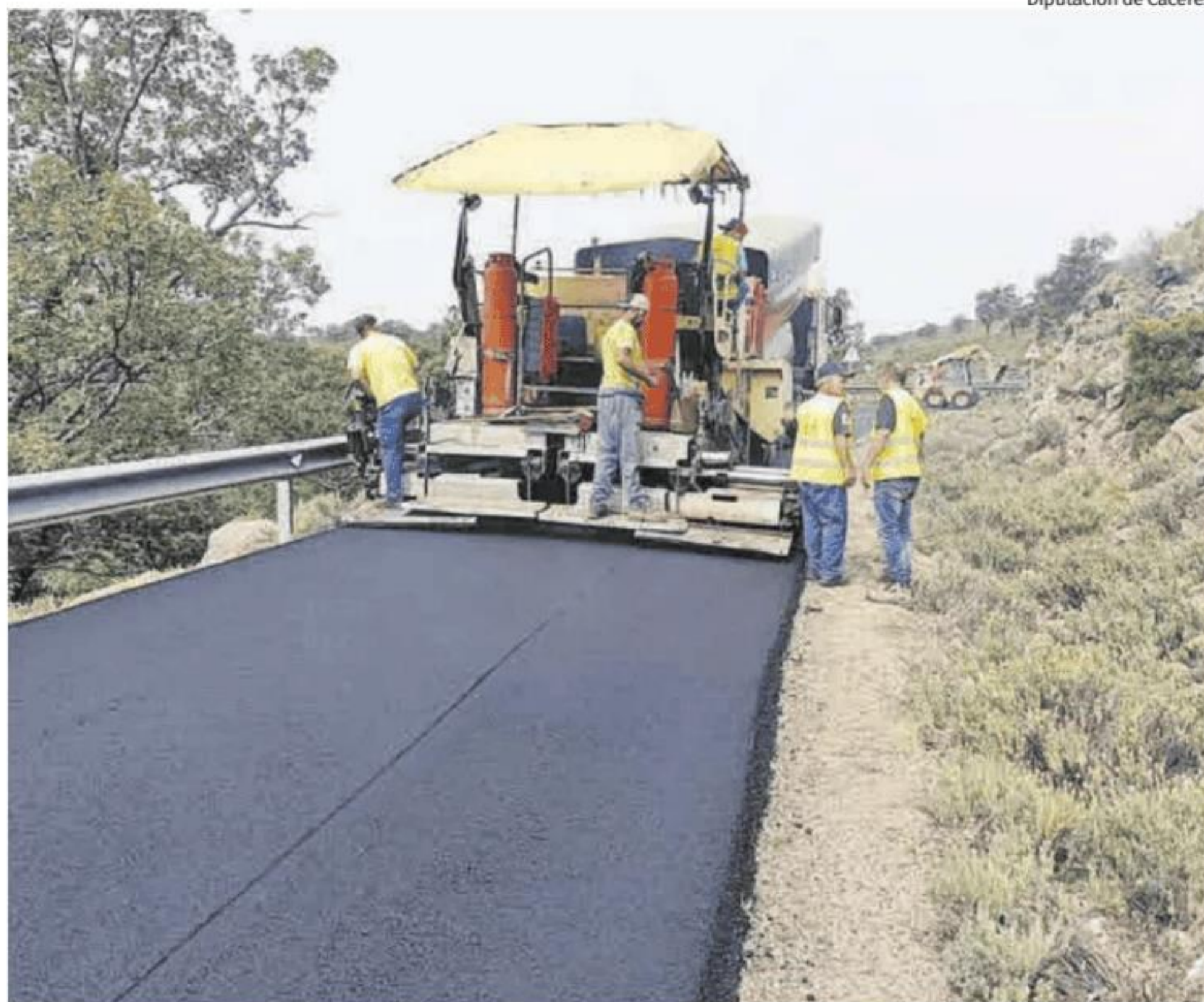
La Diputación rehabilita la carretera del Puerto de Honduras.
